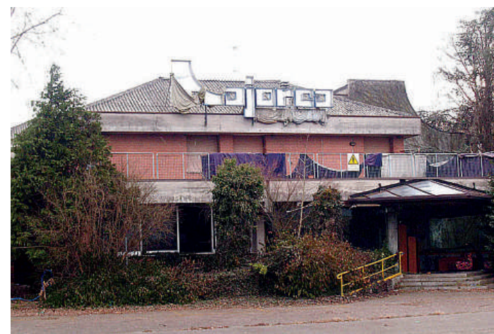
La discoteca chiusa dal 2005 è rifugio di senzatetto
