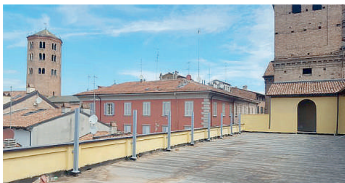
I lavori di ristrutturazione dell'ex collegio e il porticato con vista sulla città
