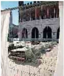
I lavori in corso in piazza Cavalli
