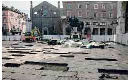
Una fase dei lavori alla pavimentazione di piazza Cavalli
